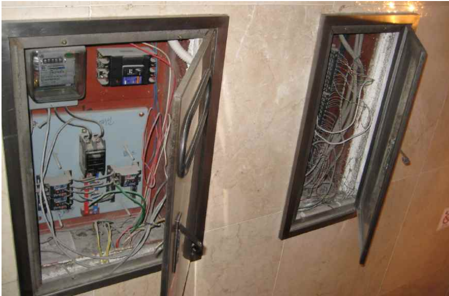
그림 3-2) 전원용 구내배관(왼쪽)과 통신용 구내배관(오른쪽)을 이용하기 힘든 경우
