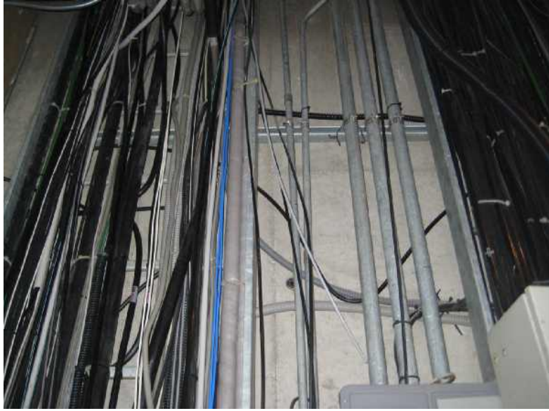
그림 3-4) 전원용 cable tray (사진의 왼쪽 부분) 와 통신용 cable tray (사진의 오른쪽 부분)를 분리하여 시설된 경우, 가운데 구내배관은 강전 케이블 용도로 사용되었다.
