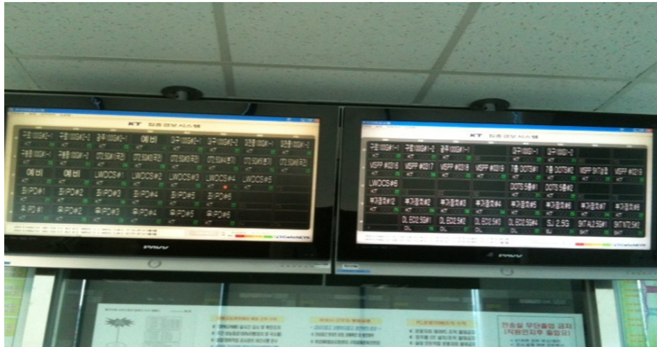
[그림 A1-9] 주요 전송로 동작상황 감시(경보)장치 사례
